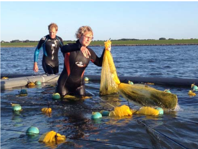
Bij Schiermonnikoog en het Uithuizerwad zijn de zakken aan een stellage bevestigd, bestaande uit een ingenieuze constructie met pijpen. Al drijvende kon de constructie naar de juiste locatie worden geduwd.
